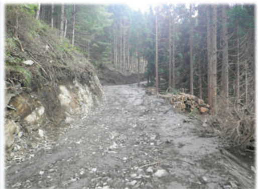
作業道整備状況写真
